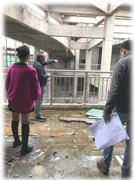
11月6日，重图张波副馆长 现场指导新馆建设
